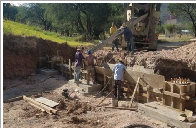
F1: Escavación, cimentación y colado
