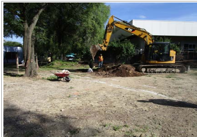
F1: Trazo y excavación
