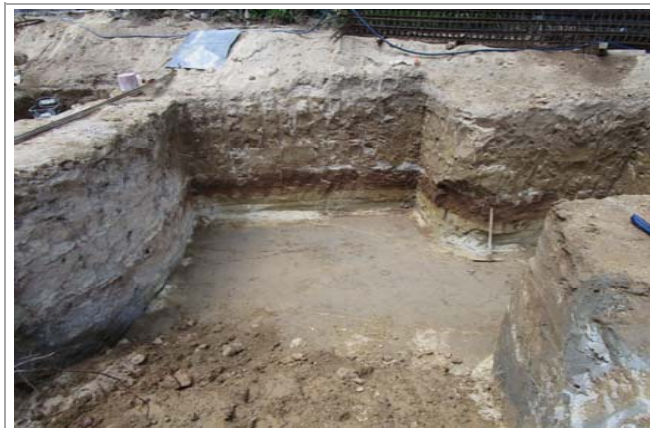
F4: Relleno y compactación en capa de cimentación
