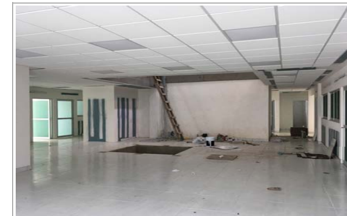
F5: Interior de aula
