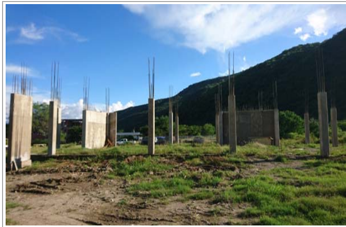
F1: Fachada principal
