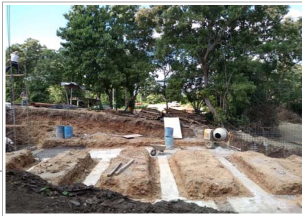
F3: Fachada posterior
