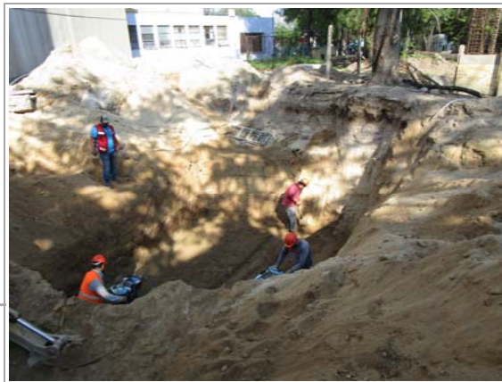
F3: Mejoramiento y relleno con material producto de excavación
