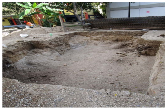
F2: Excavación en caja 0.00 A -2.00 M
